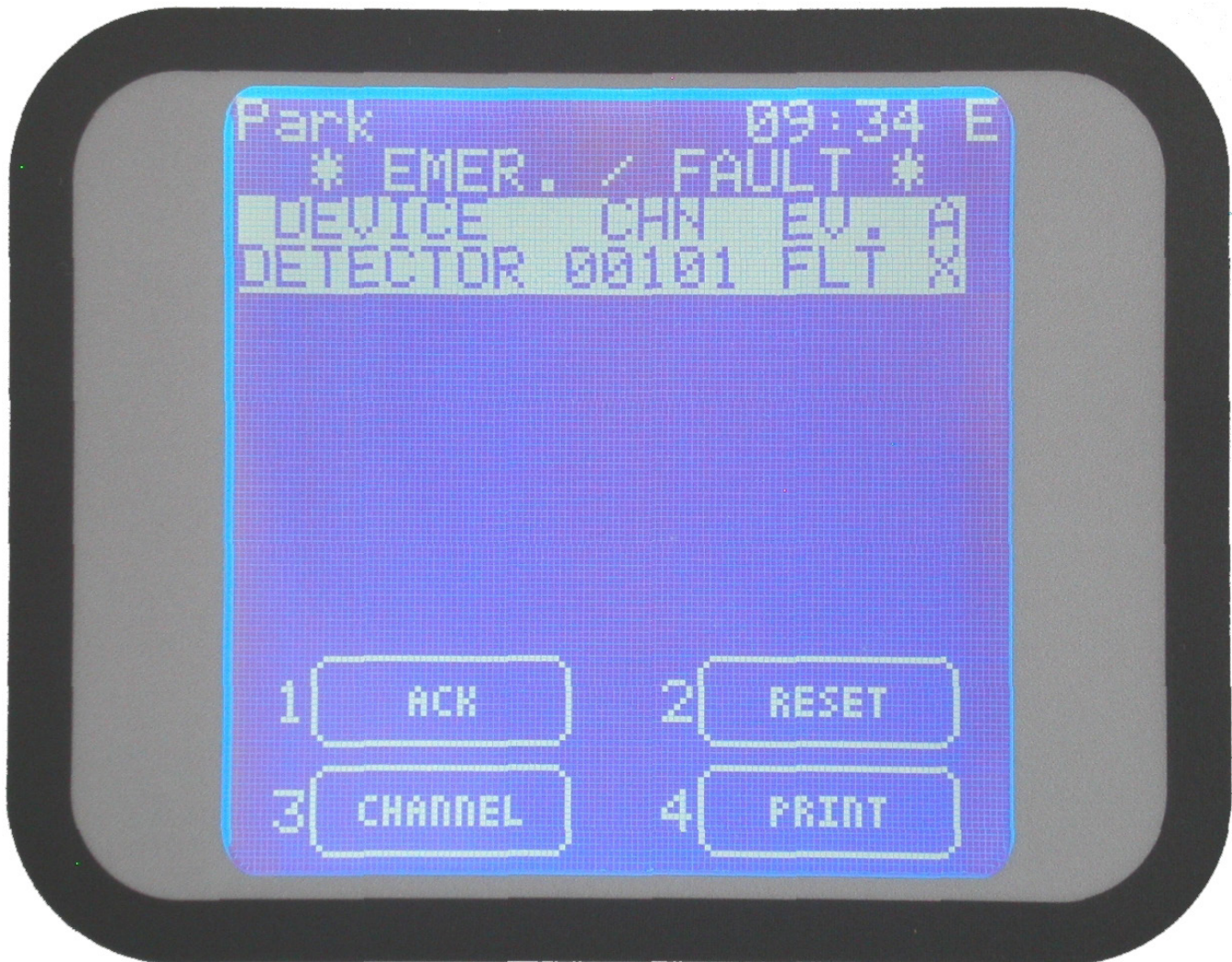
Figura 27 Videata in stato di Guasto
